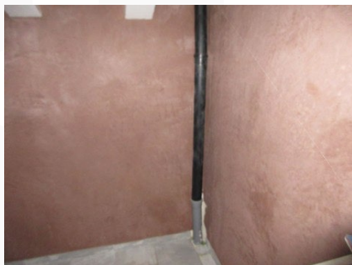
Descente d'eau à l'intérieur
