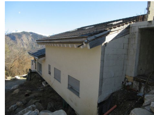
Vue façade Nord
