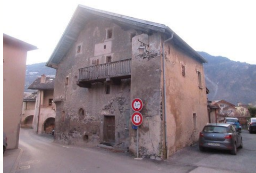
Vue angle Nord-Ouest
