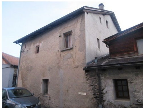
Vue angle Sud-Ouest
