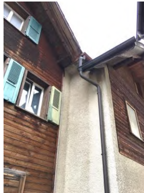
Stromleitung Dachrinnenheizung
