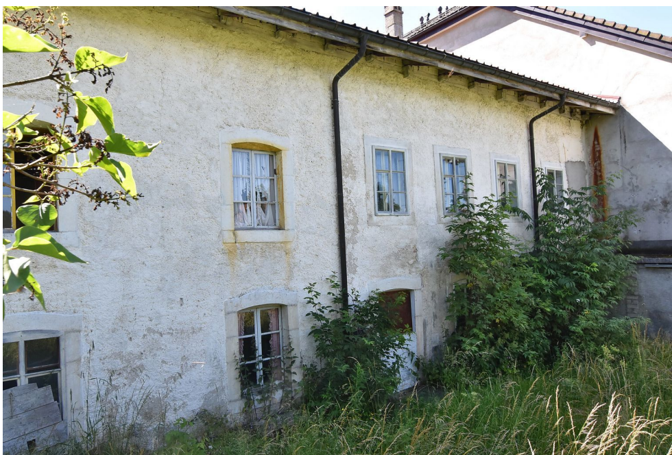
Photo N°5 Façade Nord-Ouest (côté jardin)
