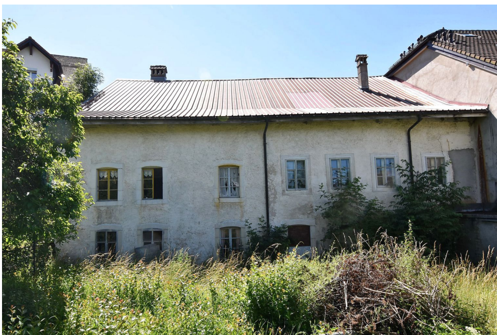
Photo N°6 Façade Nord-Ouest (côté jardin)
