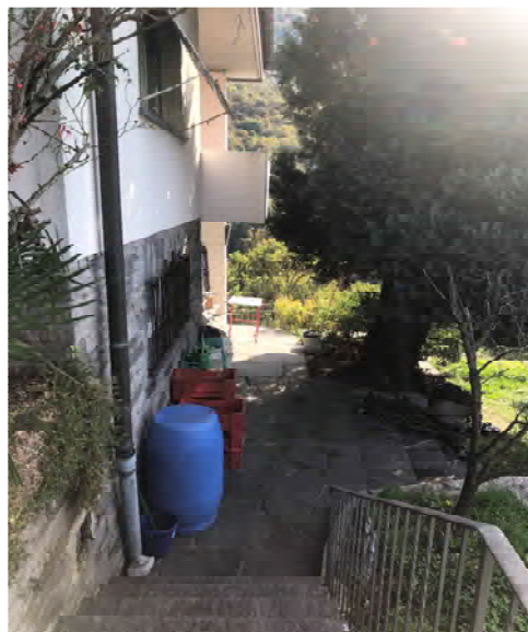
camminamento fronte ovest edificio
