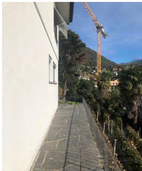
camminamento fronte sud edificio
