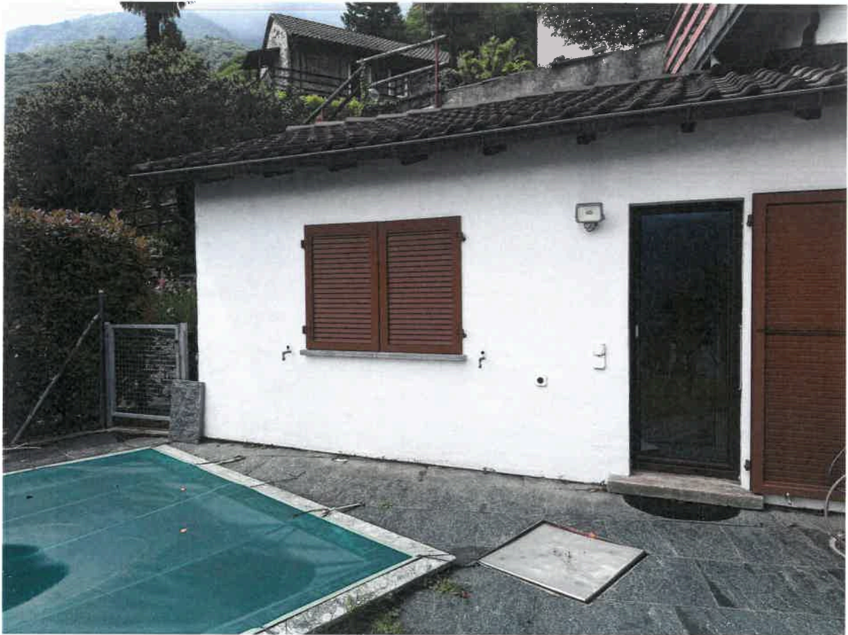
Camera PT prospiciente piscina
