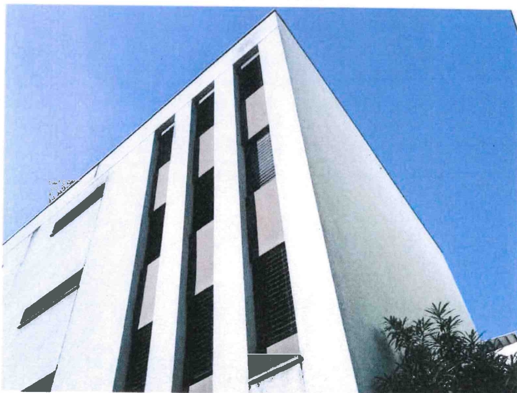
Facciata verso la strada
