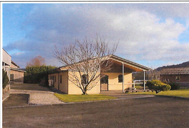
Pferdestall Süd Assek.-Nr. 357: Ansicht von Nordwesten
