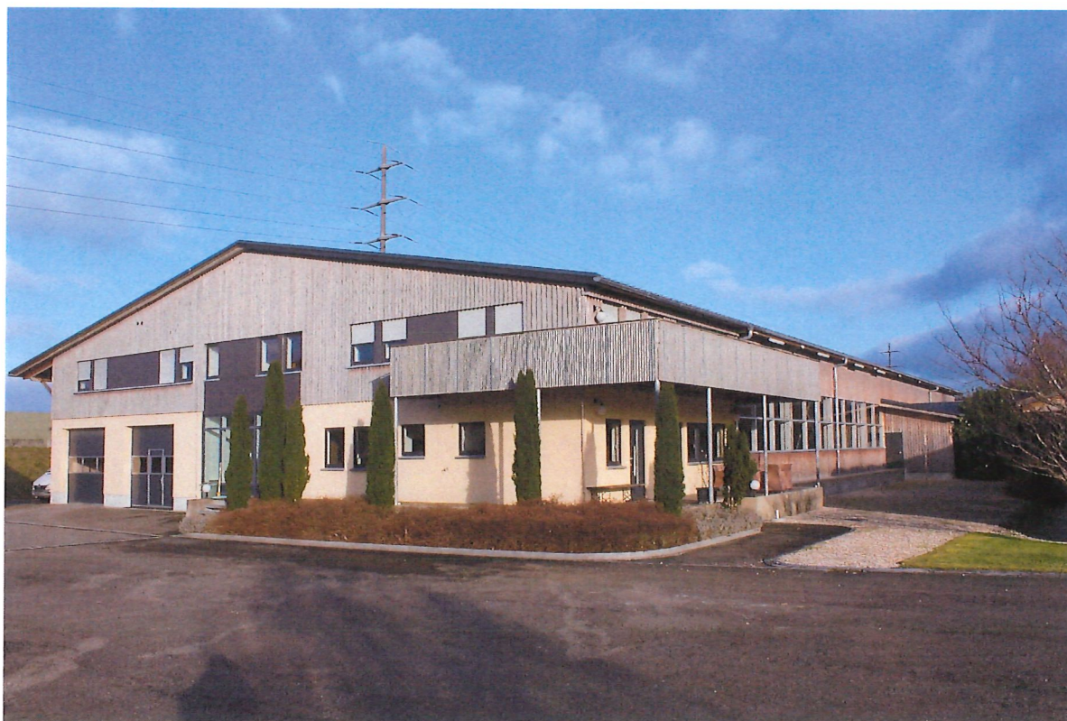
Reitsporthalle mit Wohn- und Gastrobereich - Ansicht von Westen
