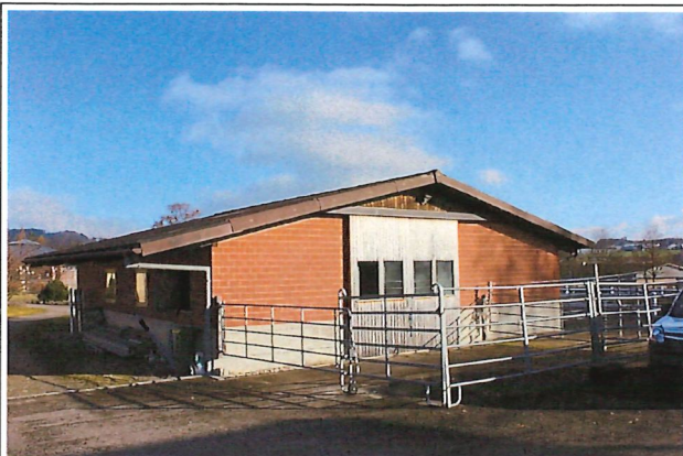
Weidestall Assek.-Nr. 303: Ansicht von Westen
