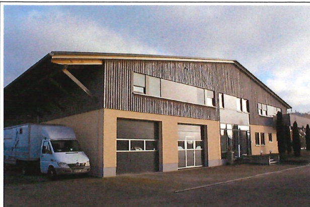
Reithalle Pferdestall Assek.-Nr. 353: Ansicht von Nordwesten
