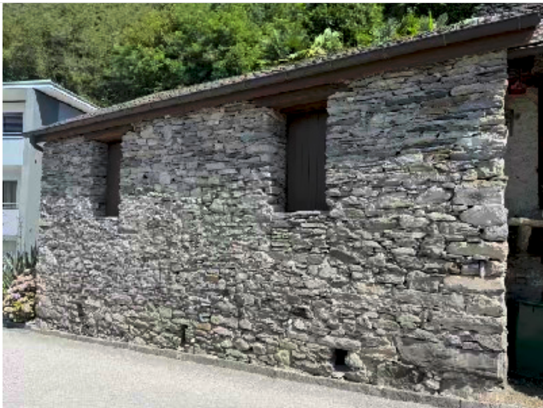
Fronte strada del rustico
