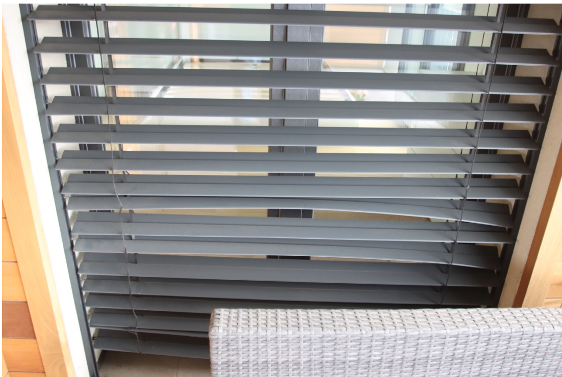
Dettaglio difetto protezioni solari
