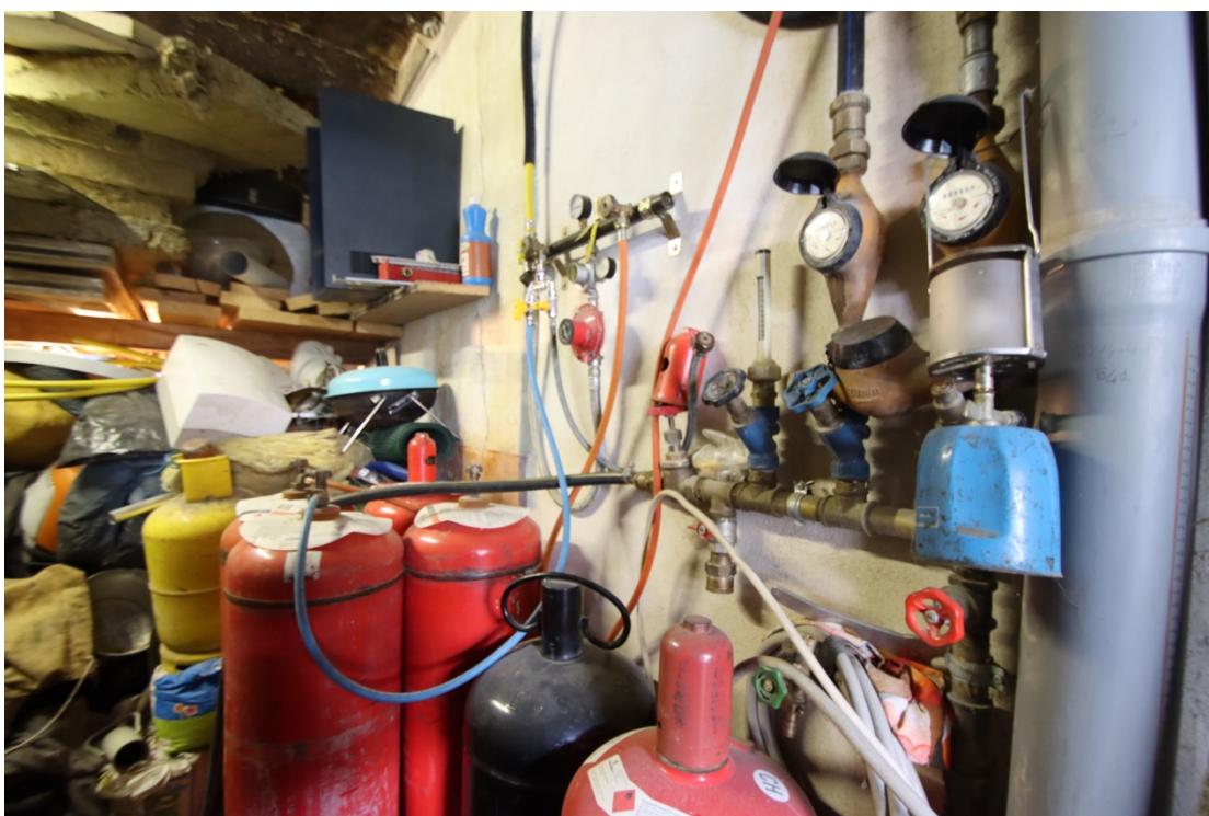
PT – Zona tecnica, stoccaggio fuori norma VKF
