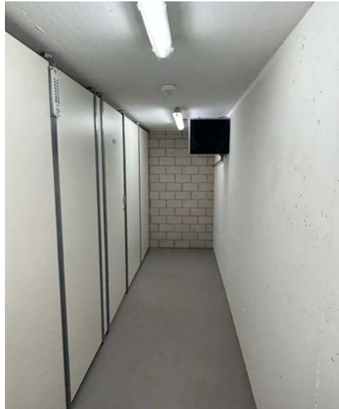
cantine corridoio piano interrato
