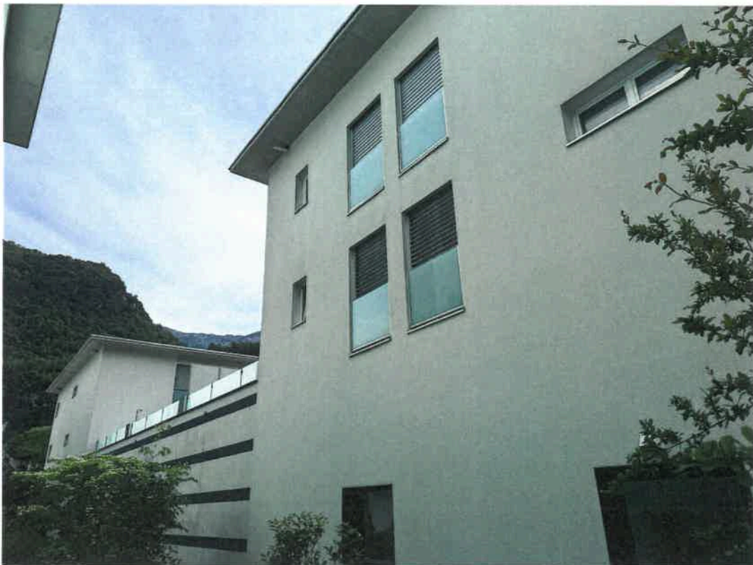
Facciata verso mapp. 312
