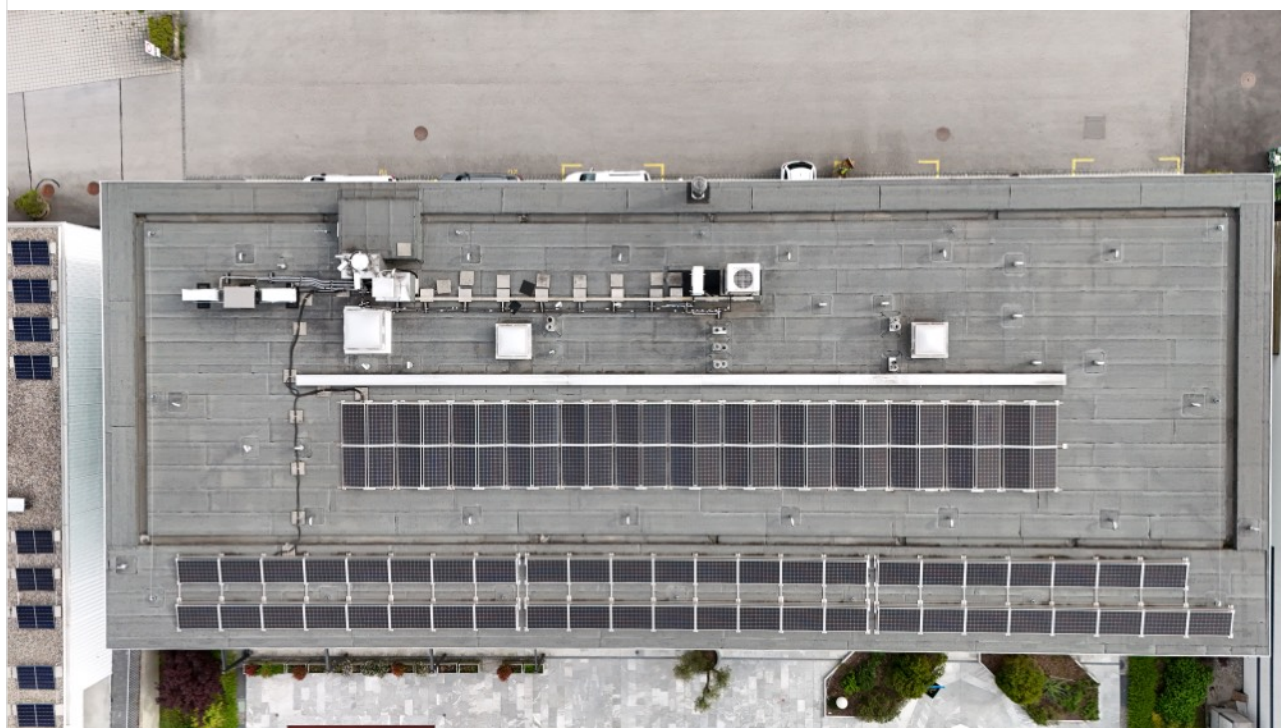
Blocco A - tetto
