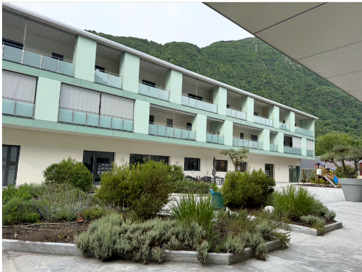
Blocco B visto dalla corte interna
