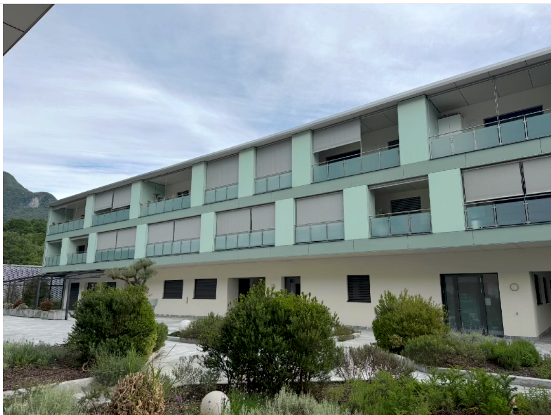
Blocco A visto dalla corte interna
